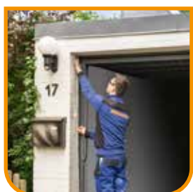
Sopralluogo per verifica dimensionale
